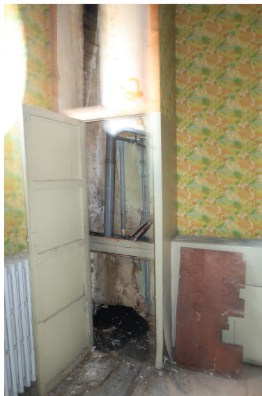
Figure 7 – origine vraisemblable de la fuite
